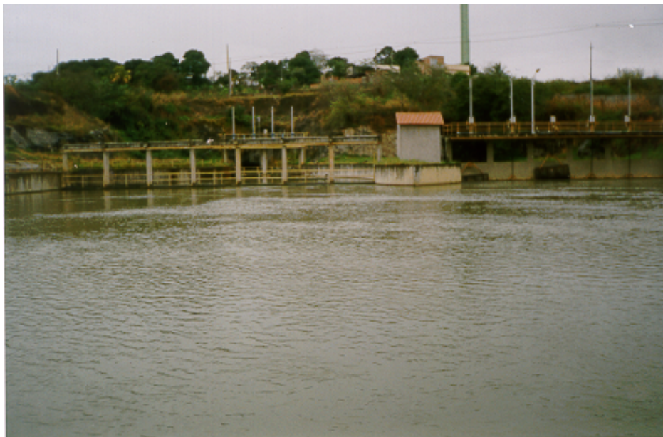
Figura 2 – A área acima dos túneis na entrada da ETA Guandu já está ocupada por residências e com encostas descobertas.
